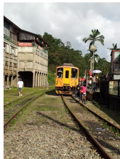
菁桐木造火車站
